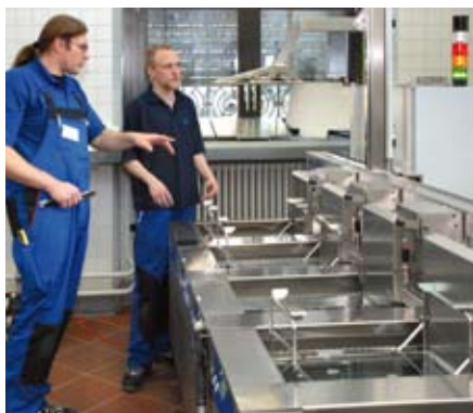
Montage der neuen Elma-Waschanlage
