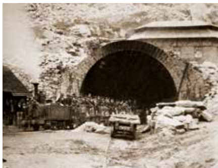
Bauzug vor dem Portal des im Bau befindlichen Gotthardtunnels (um 1880)
